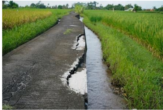
Gambar 1. Kondisi Saluran Tersier Subak Laud
