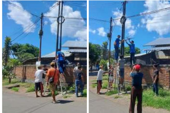
Gambar 2. Pemasangan lampu solar panel
