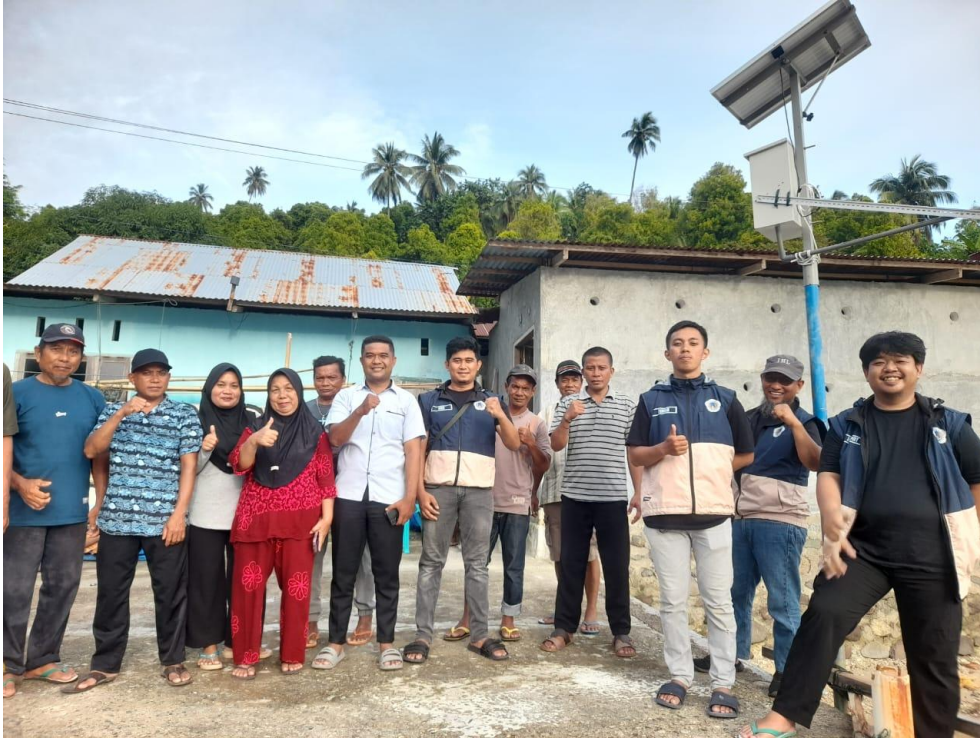
Gambar 2. Pemasangan Alat Pemantau Pasang Surut Air Laut bersama-sama dengan mitra
