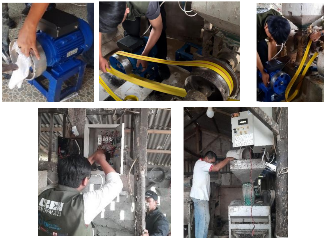
Gambar 10. Proses Instalasi dan Uji Coba
